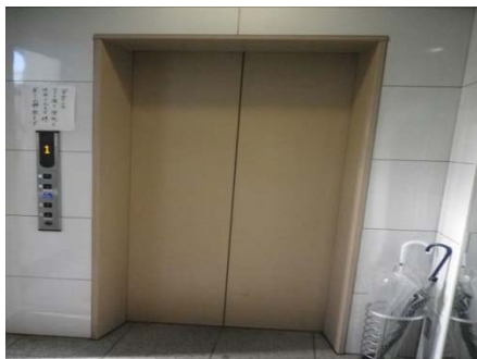
エレベーター前
