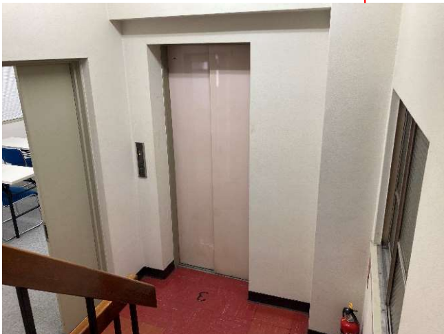
エレベーター前、入口前
